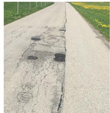
einer 6 bis 8 cm starken Trag-Deckschicht überzogen. Die Bankette werden abgegraben und nach der Asphaltierung wieder angeglichen.
